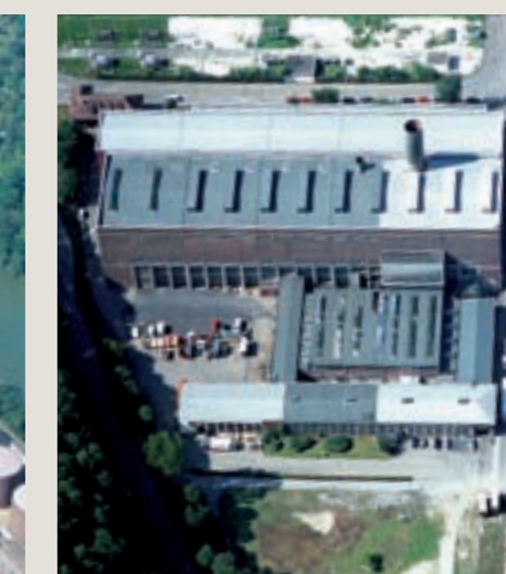
Verschiedenste Trainingsstationen befinden sich im Kesselhaus
