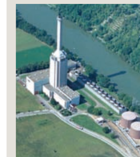
Der Außenbereich am Turm bietet Übungshöhen bis zu 150 m
